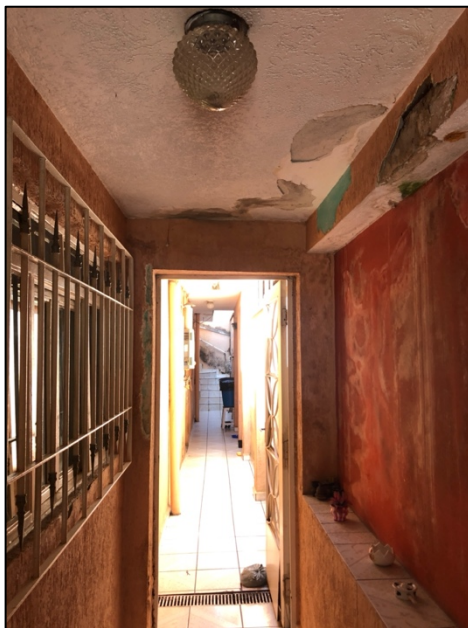
Foto 8 – Corredor de acesso à área de serviço
