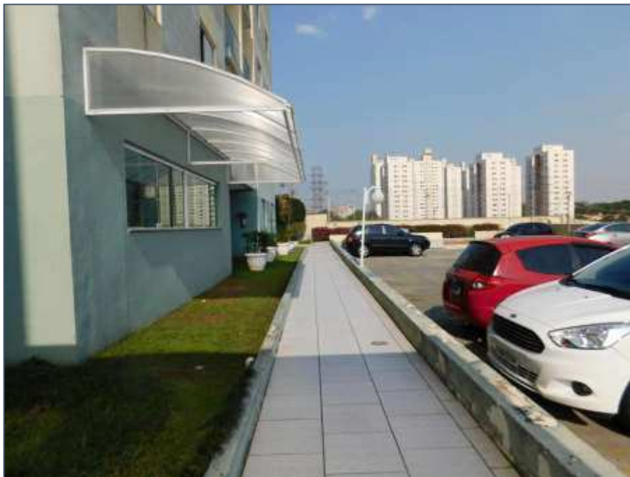
Foto nº 52 - Área externa do condomínio
