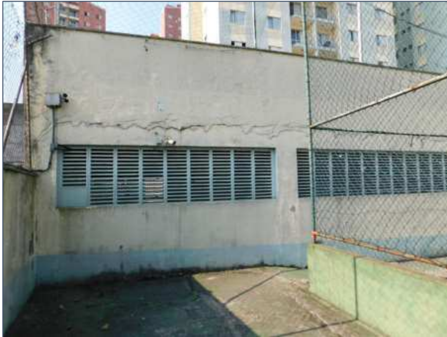
Foto n° 45 - Área externa do condomínio
