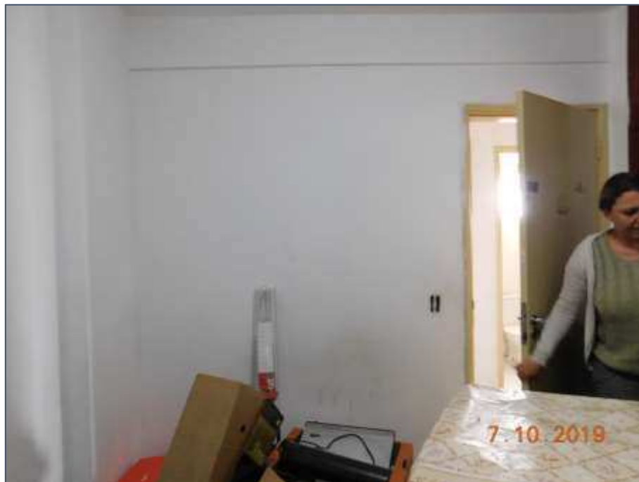
Foto nº 13 - 13º andar - Dormitório 1
