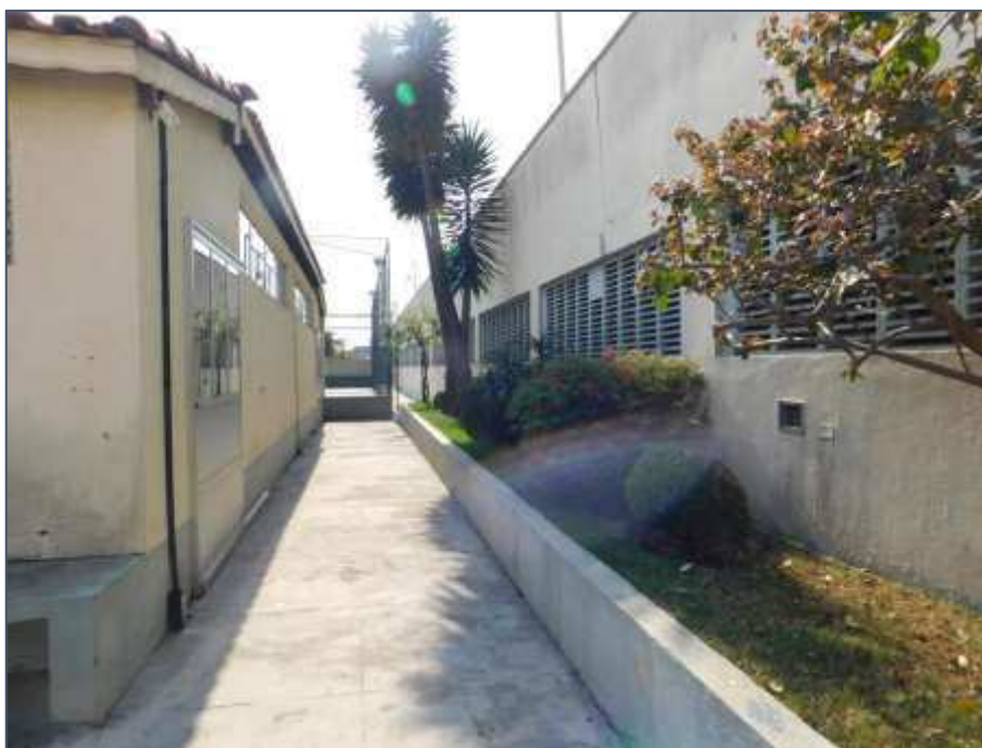
Foto nº 49 - Área externa do condomínio
