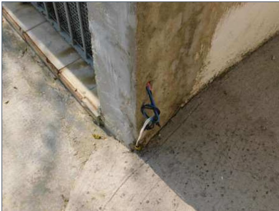
Foto n° 48 - Área externa do condomínio
