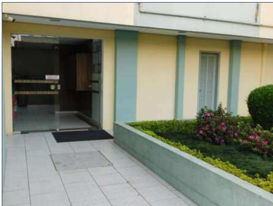
Foto nº 38 - Área externa do condomínio
