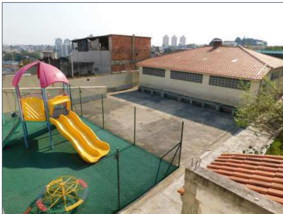
Foto n° 50 - Área externa do condomínio
