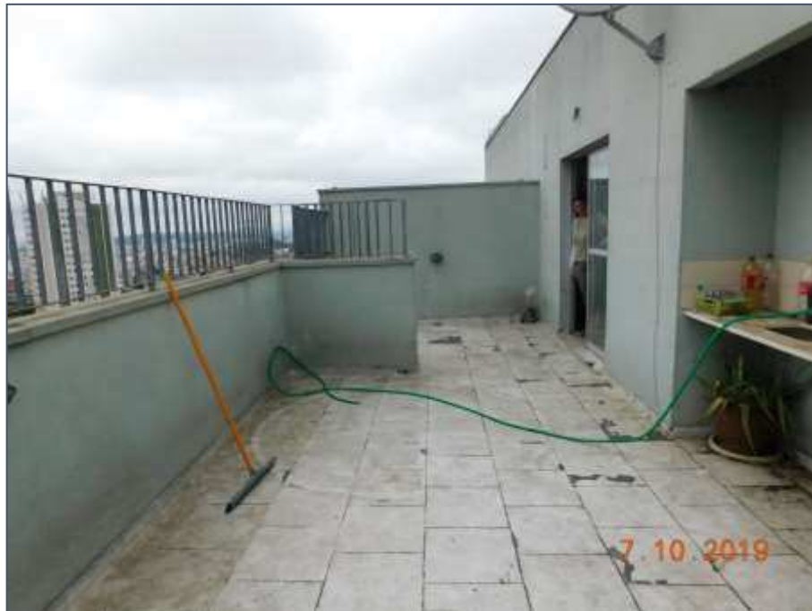
Foto n° 34 - 14° andar - área externa
