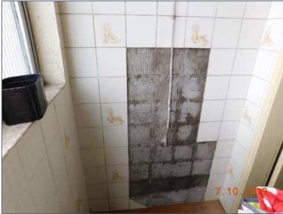
Foto nº 23 - 13º andar - lavanderia
