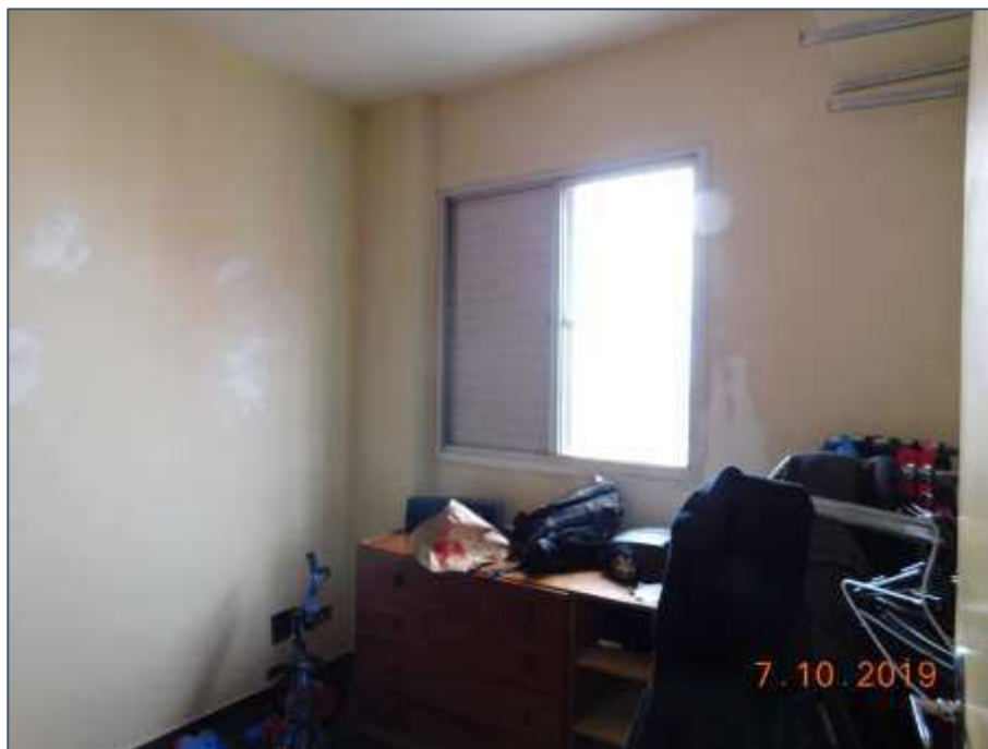
Foto nº 14 - 13º andar - Dormitório 2
