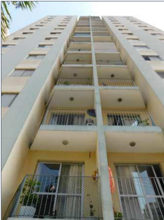
Foto n° 2 - Fachada Edifício Gurupa
