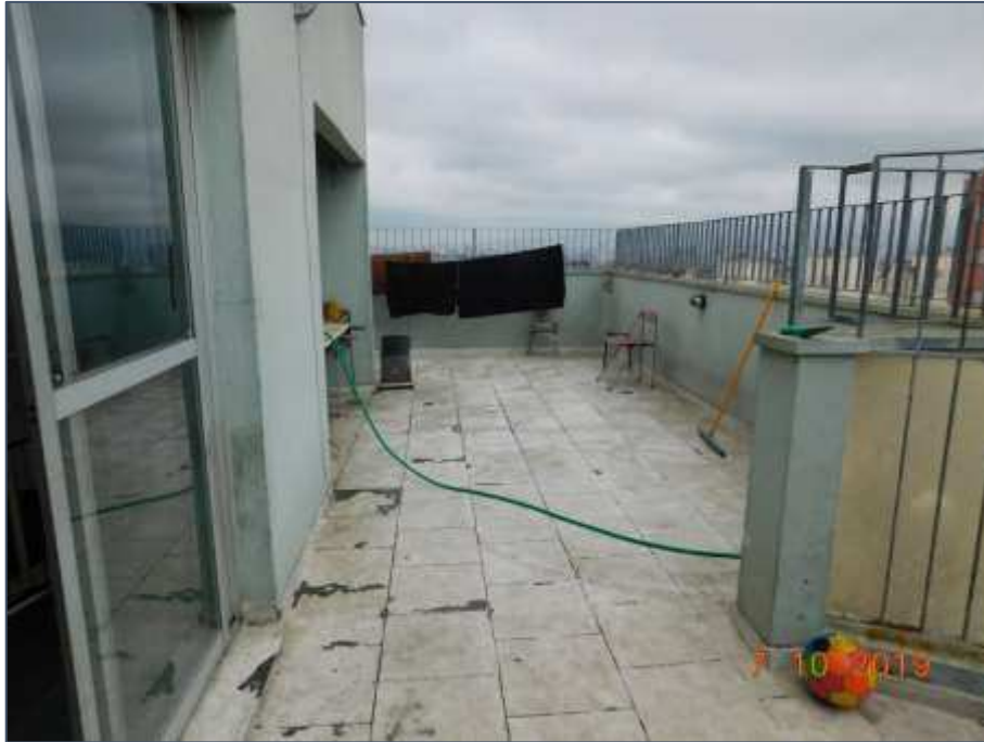
Foto n° 33 - 14° andar - área externa
