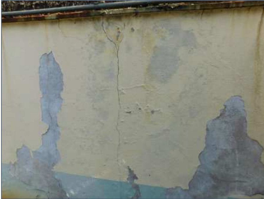
Foto n° 47 - Área externa do condomínio
