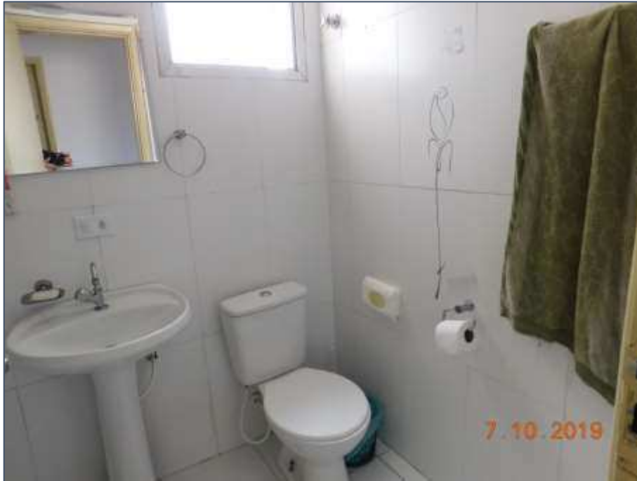
Foto nº 18 - 13º andar - banheiro
