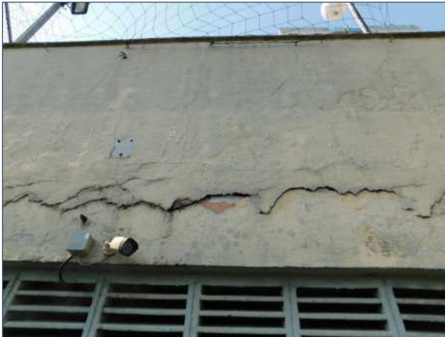
Foto n° 46 - Área externa do condomínio
