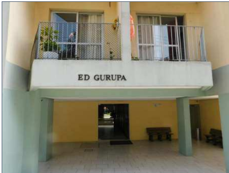
Foto n° 3 - Fachada Edifício Gurupa
